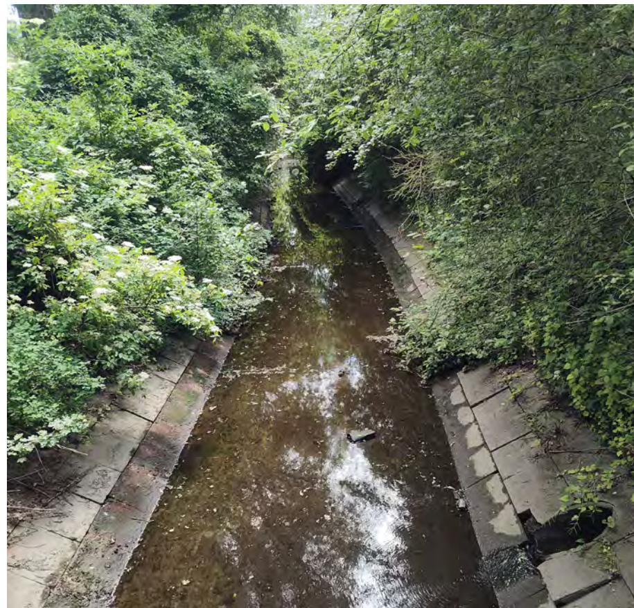
Harrestrup Å langs med Stadionparken, som i fremtiden skal kunne håndtere store mængder regnvand
